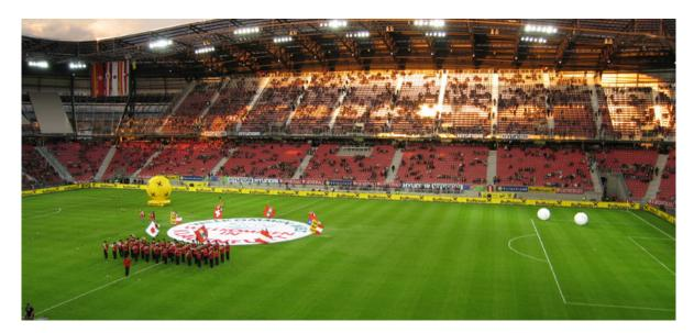
El estadio Wörthersee de Klagenfurt es el más moderno de Austria. El edificio destaca por sus atractivos elementos arquitectónicos que se integran de forma óptima en el paisaje. La construcción de la cubierta, a modo de celosía de acero en forma de hoz con una supestructura a base de vigas secundarias, constituye la estructura portante de la misma.
