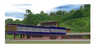
Se trata de un edificio de tres plantas estrechas (baja +2 alturas), que permiten la ventilación natural cruzada, dispone de un frente acristalado protegido con parasoles y con distinta configuración (ventana, galería o invernadero), según el espacio al que sirva, para precalentamiento del aire de calefacción o para promover la ventilación.
