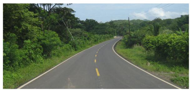
Consiste en la rehabilitación 17,5 km de carretera y calles de los distritos de Soná, Río de Jesús y Las Palmas, mediante escarificación y conformación de la calzada, colocación de carpeta de hormigón asfáltico caliente, doble sello, y parcheo profundo y superficial.
